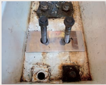
Pernos revisados antes de ser montados con la nueva pletina.
