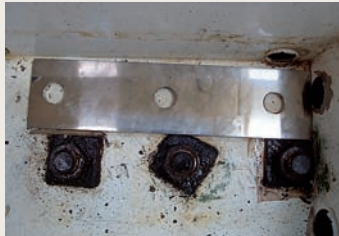
Los pernos antes de ser revisados, con la pletina que sustituyó a las viejas pletinas.
