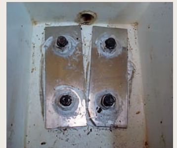
Los pernos, revisados, con las nuevas pletinas.
