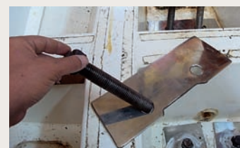
Detalle de los pernos y de las nuevas pletinas.
